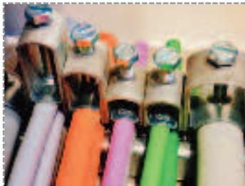
I fissacavi possono essere in nylon o in acciaio. Vanno montati fuori dall'attacco sia sul punto fisso che nel punto mobile.
